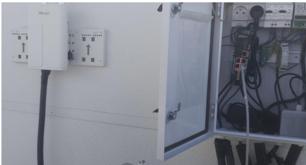
Installation terminée sur le toit
